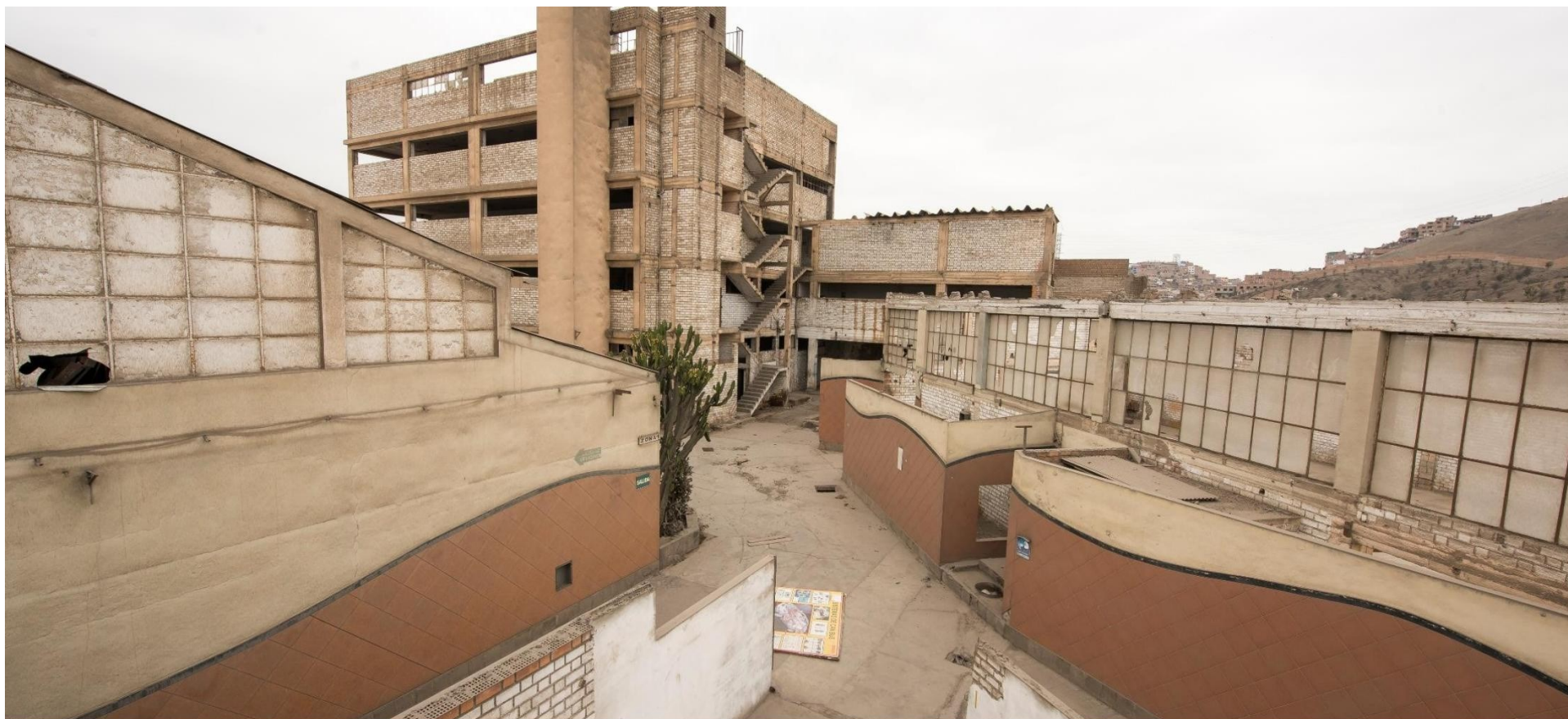
Vista Segundo piso
